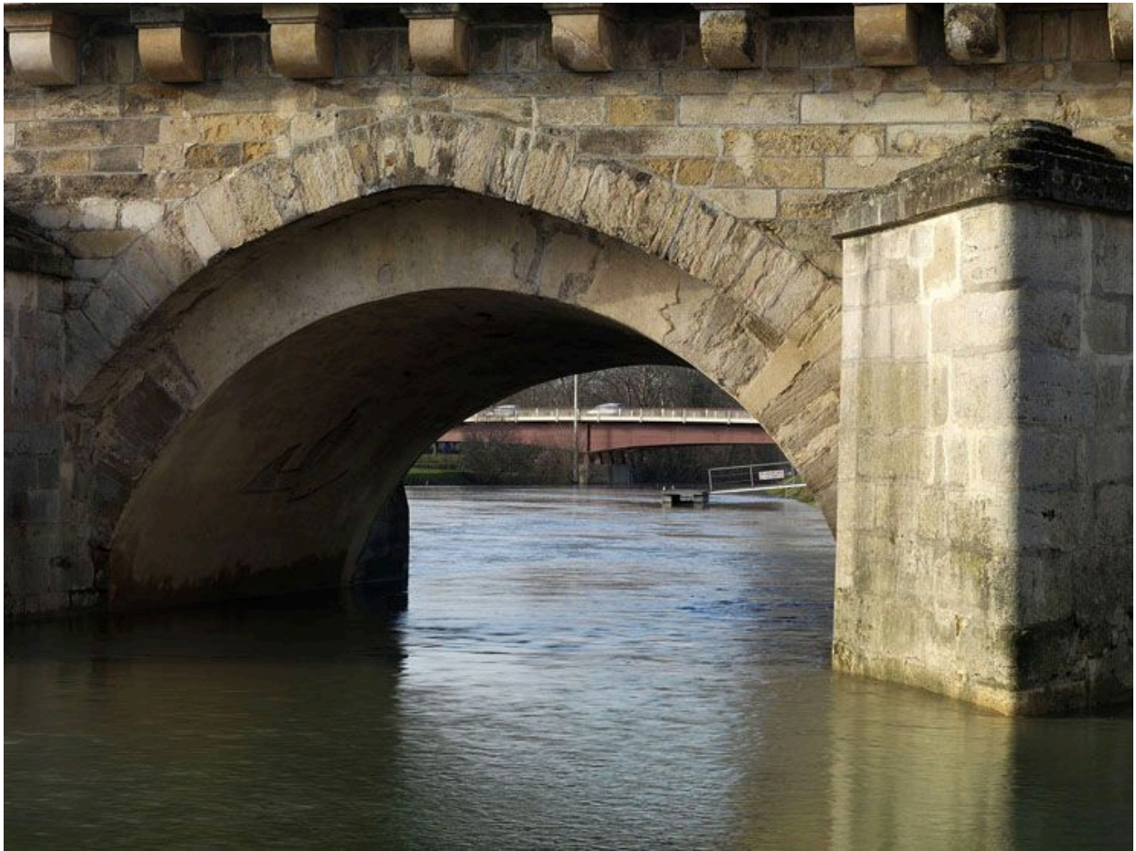
Meulan : ancien pont sur le bras de Meulan.
