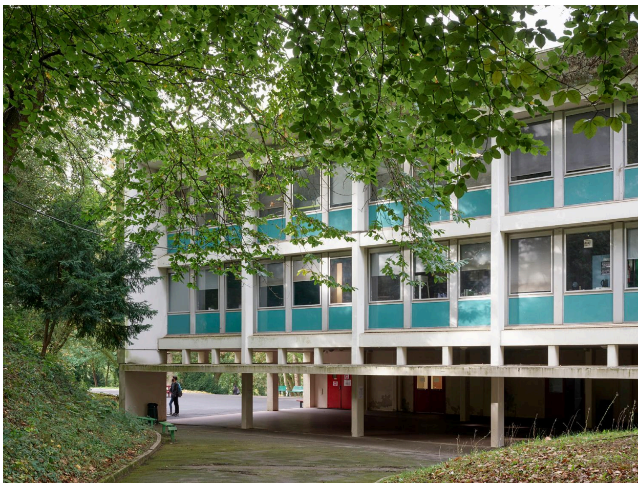
Le bâtiment de l'actuel lycée (façade postérieure sur cour).
