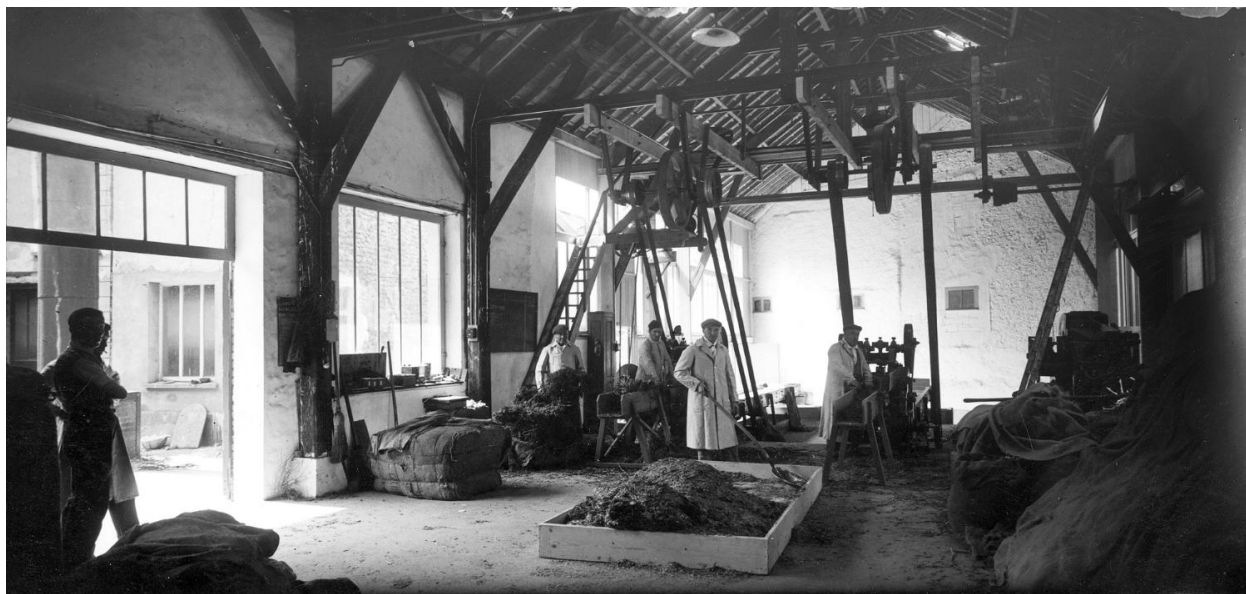
Vue intérieure du bâtiment L, abritant les machines à couper (ou broyer) les plantes.
