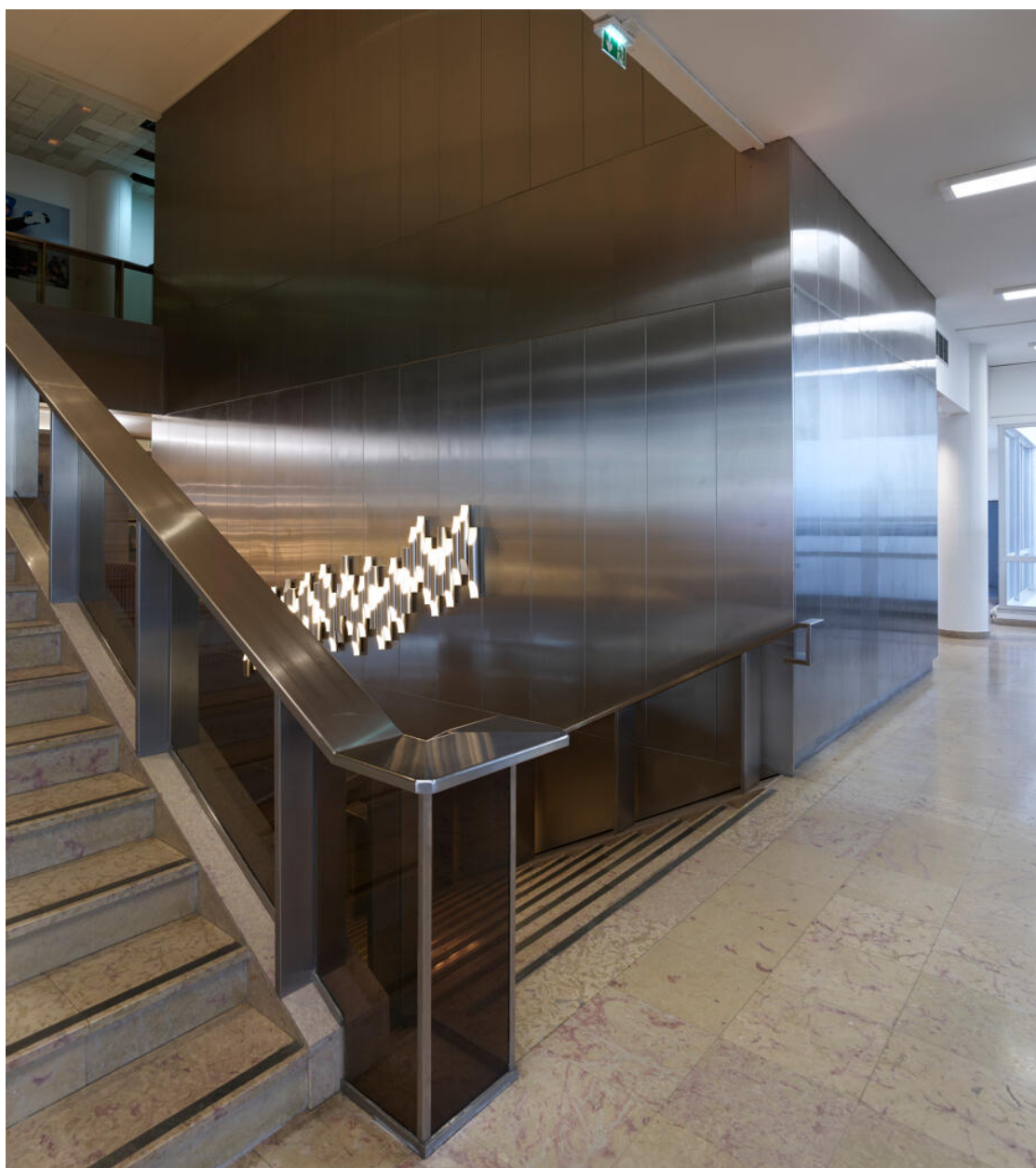
Escalier principal (escalier d'honneur), vue depuis le premier étage. Dessiné par G. Picquenard. Rampe en inox et garde-corps en verre fumé, revêtement en travertin. Luminaire composé par G. Picquenard à partir de tubes individuels préexistants.
