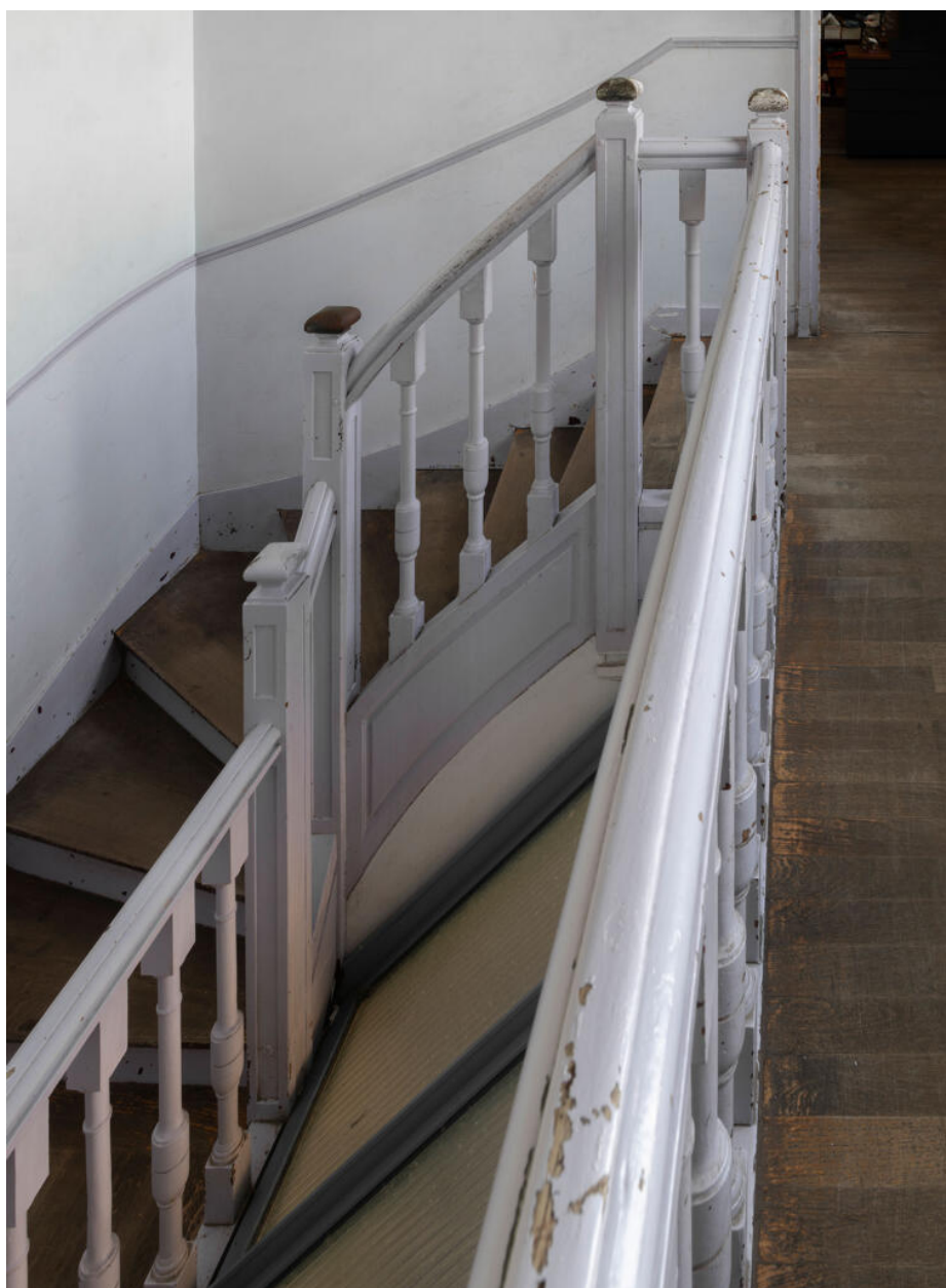
L'escalier principal, en bois peint.
