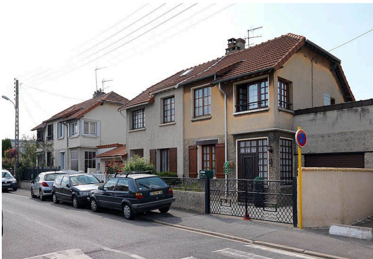
Orly, maison jumelée, 9 rue Georges Baudelaire. Vue d'ensemble.
