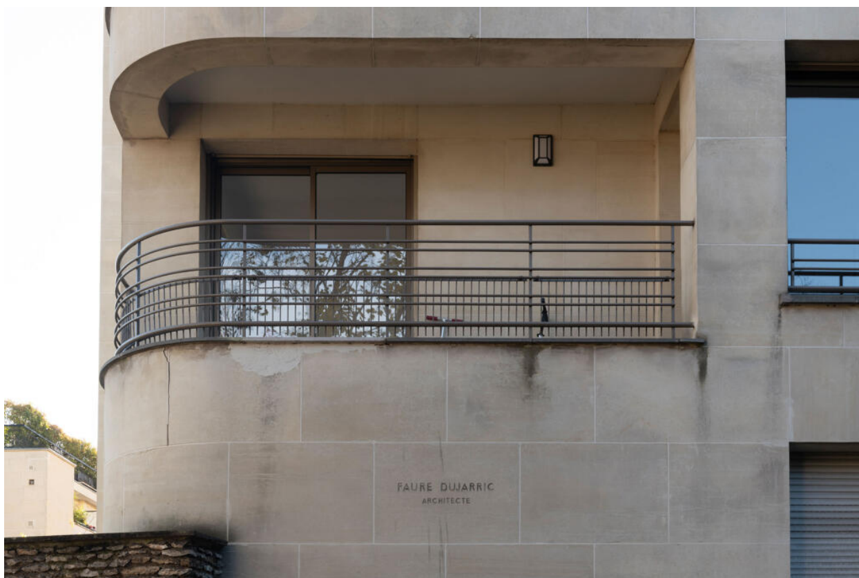
Ensemble des Gâte-Ceps, terrasse à garde-corps style paquebot
