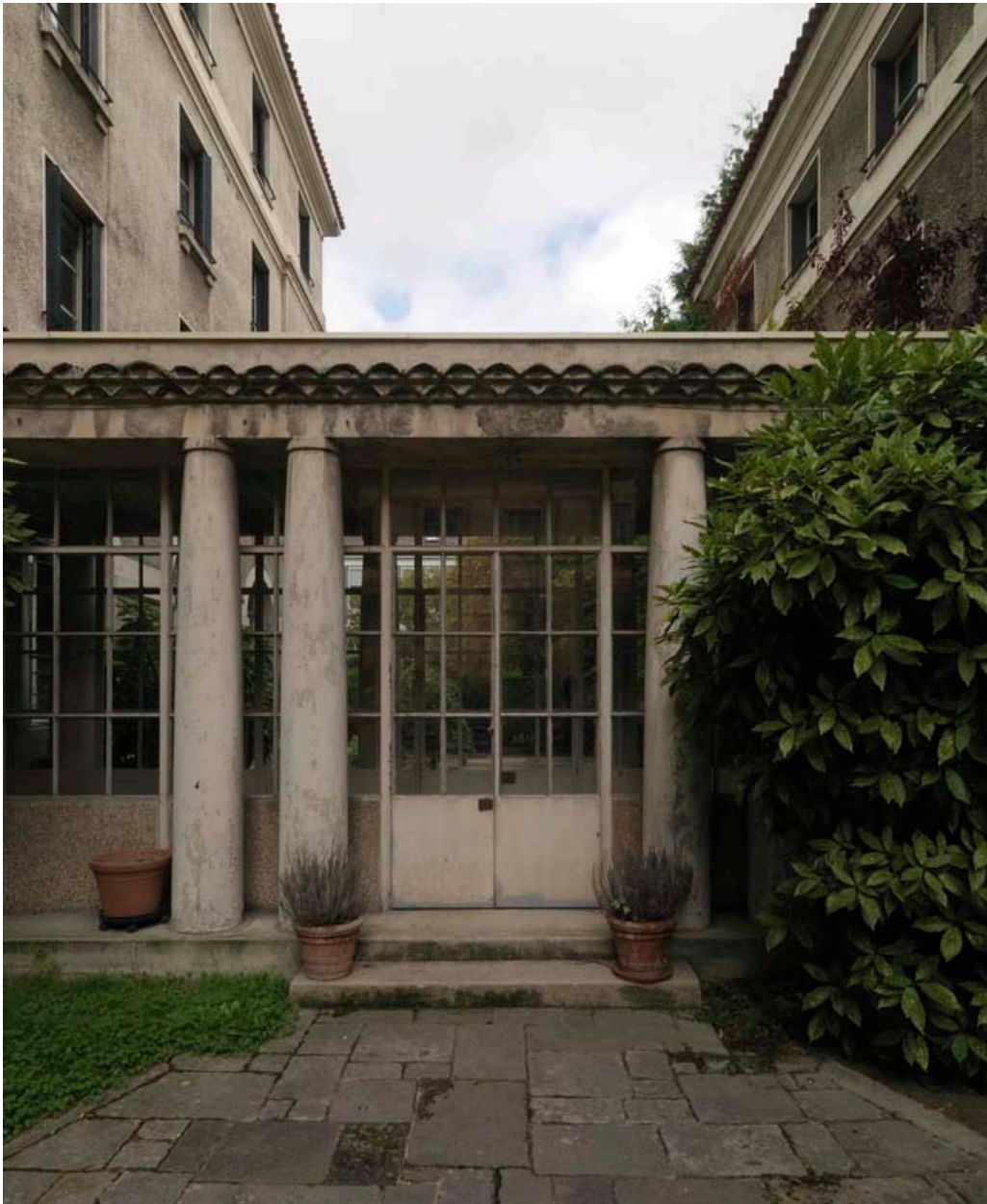
Vue du passage couvert reliant les deux bâtiments.
