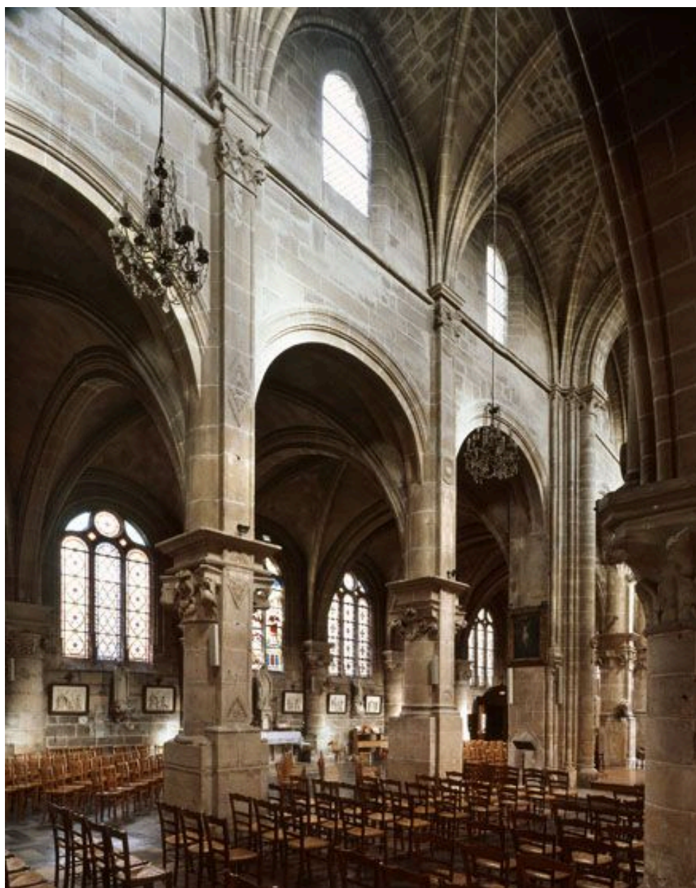
Vue d'ensemble des travées de la nef ouvrant sur le bas-côté.
