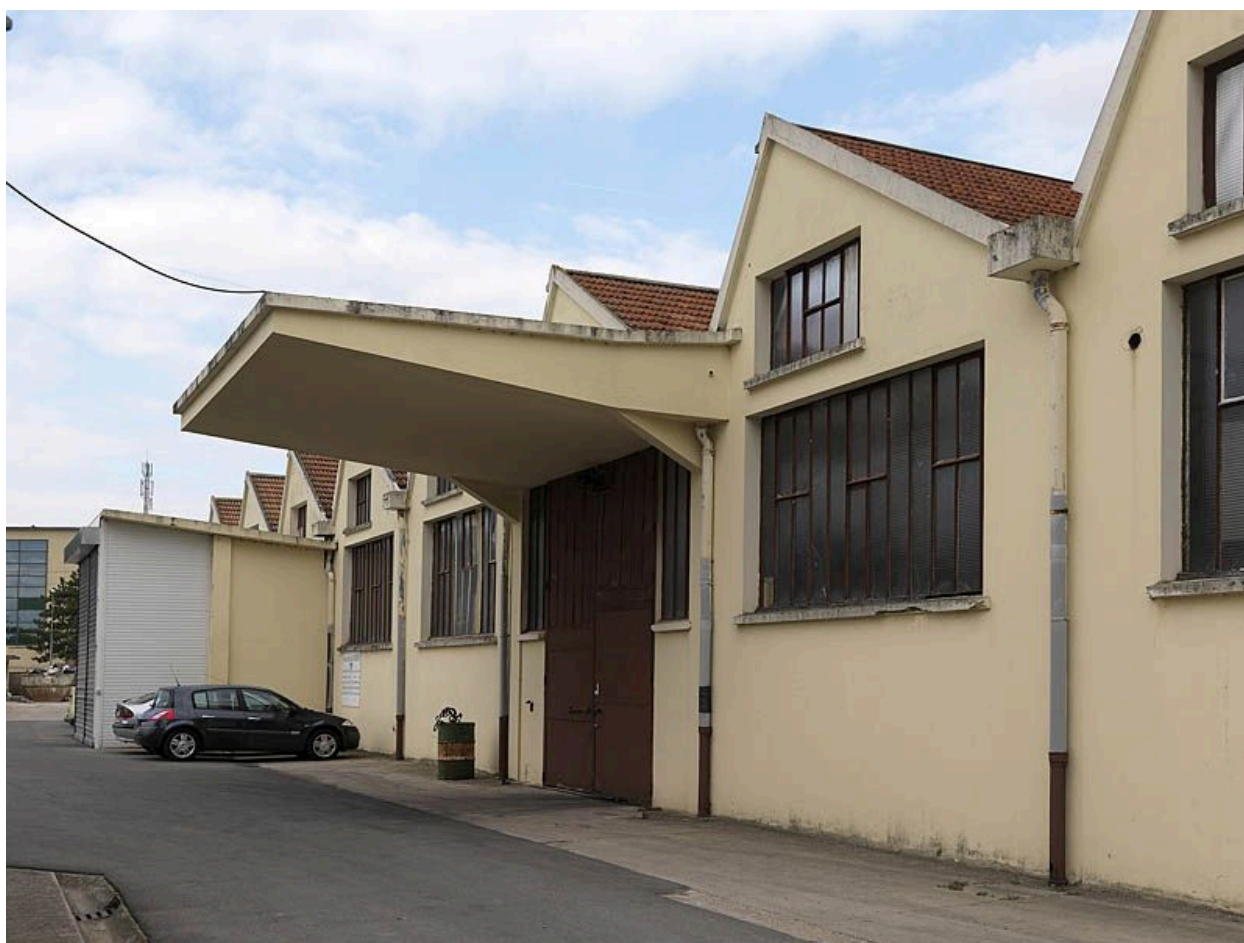
Entrée d'une des actuelles unités de stockage. Auvent en béton.
