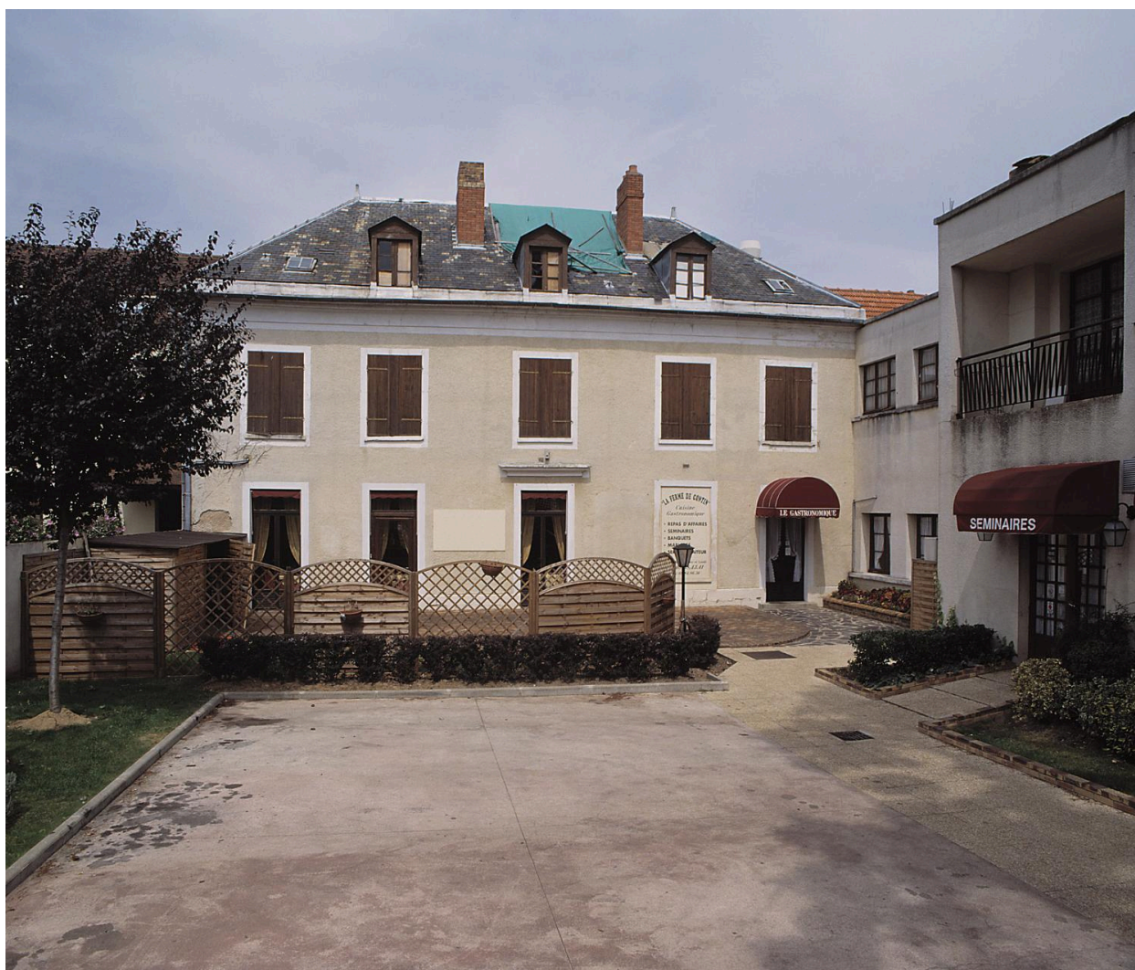
Vue d'ensemble de la maison de maître sur l'avenue Aristide-Briand (n° 56).
