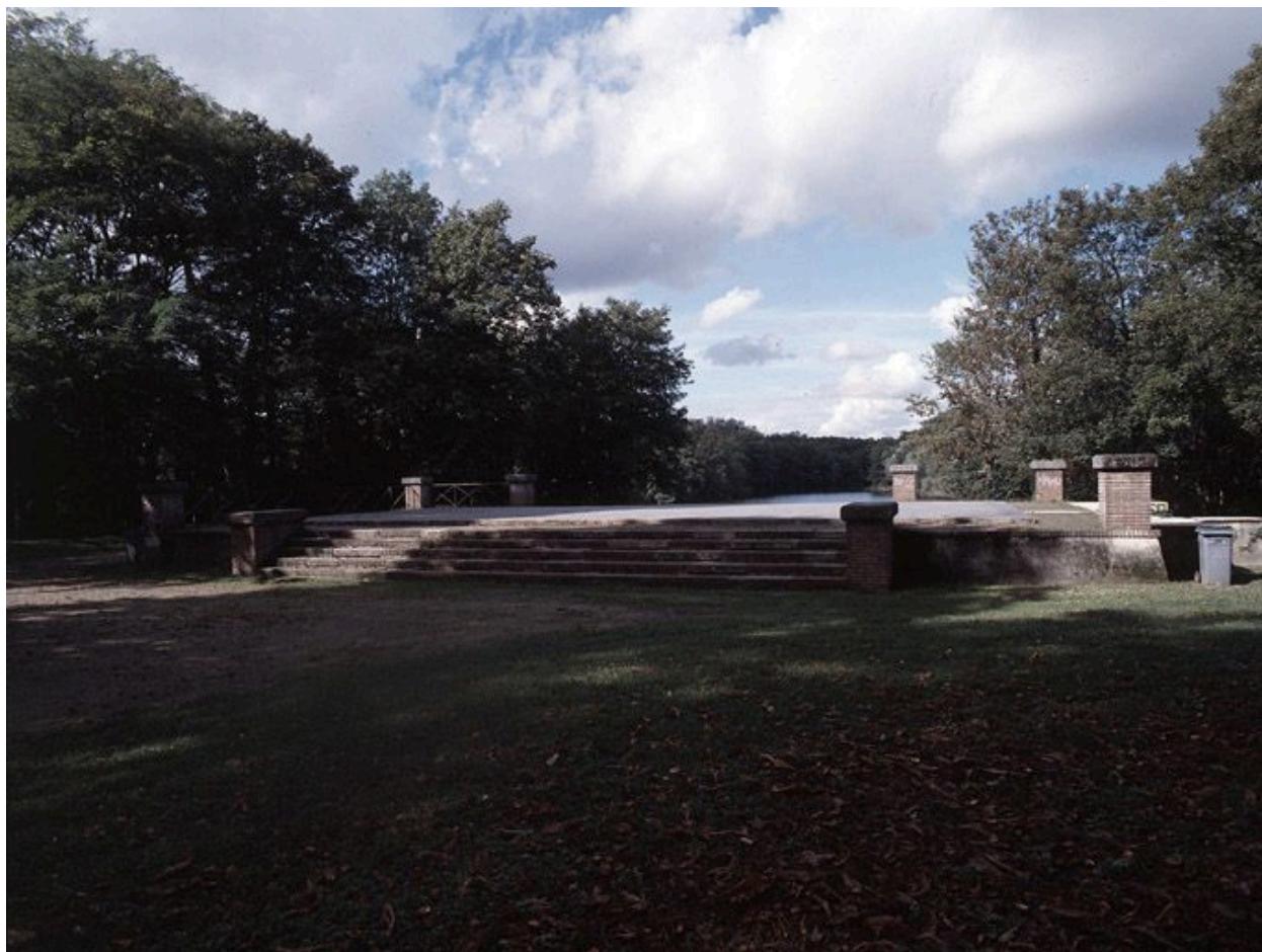
Plateforme constituant le soubassement de l'ancien château arasé en 1975.
