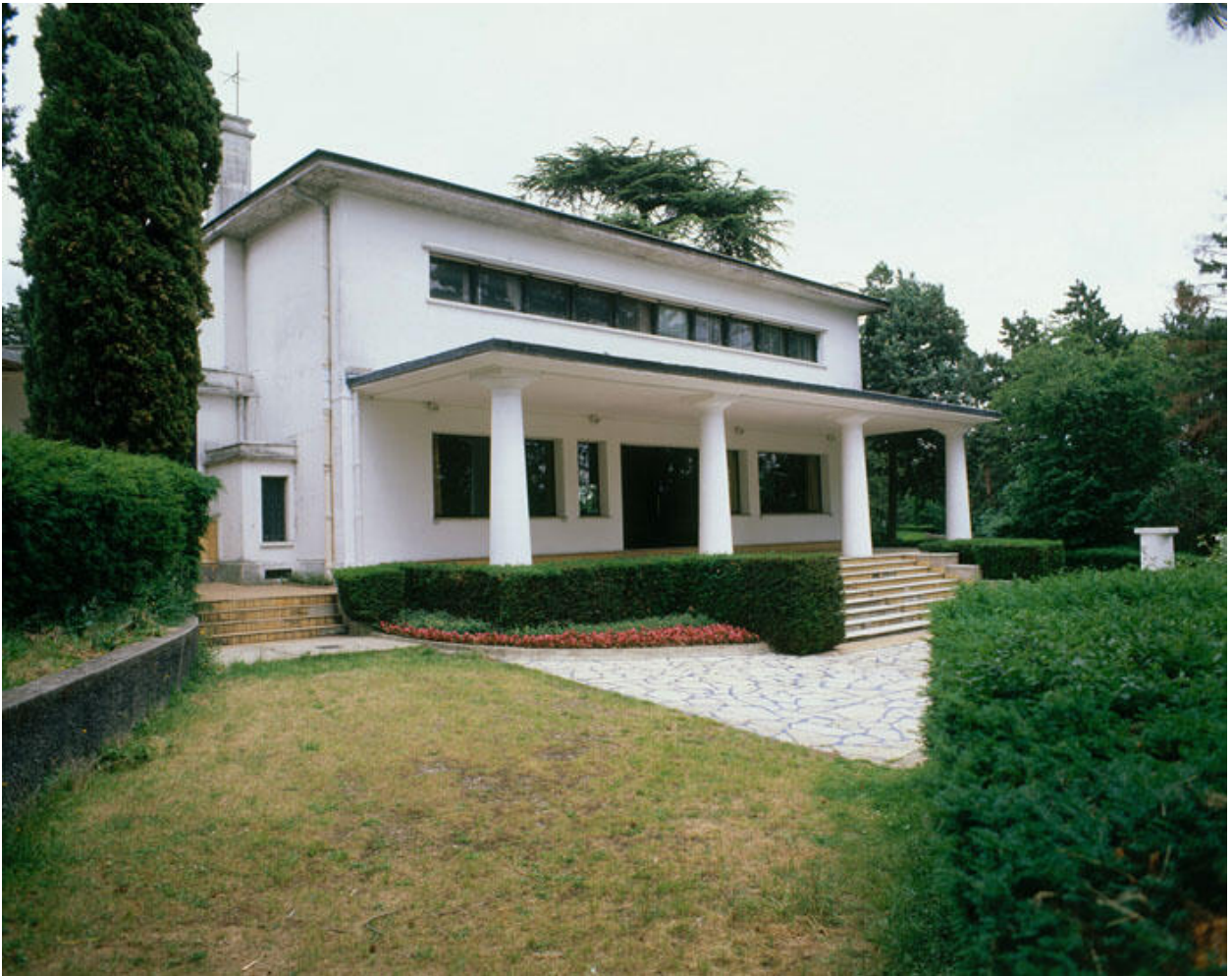
Façade sud à portique. Maison de maître dite Le Moulin Fidel
