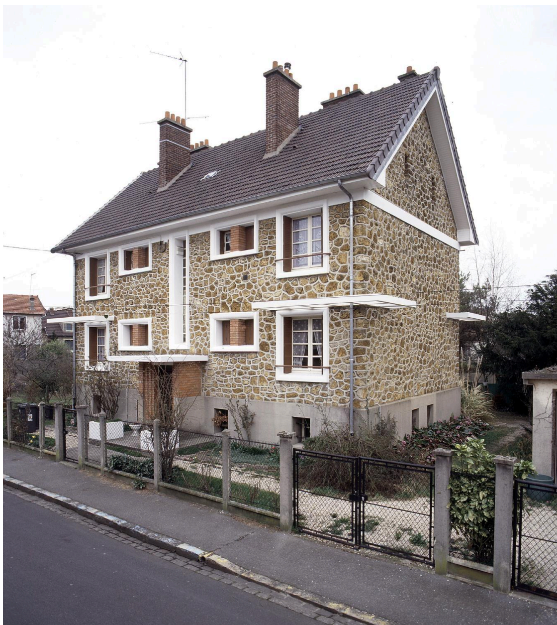
Maison d'habitat collectif à logements multiples située 20, rue de la Paix.
