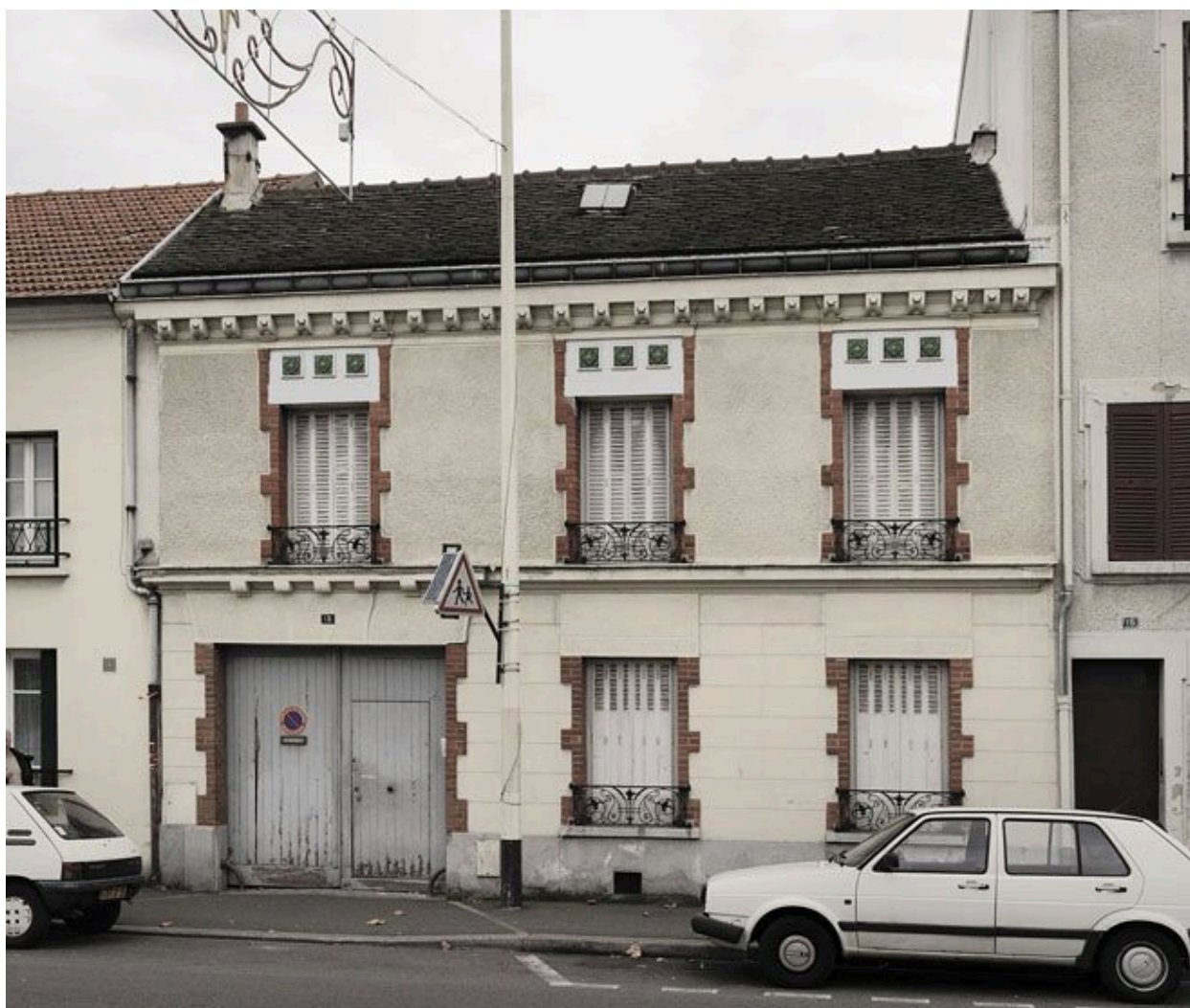
Maison à porte charretière, 13 rue de Paris.
