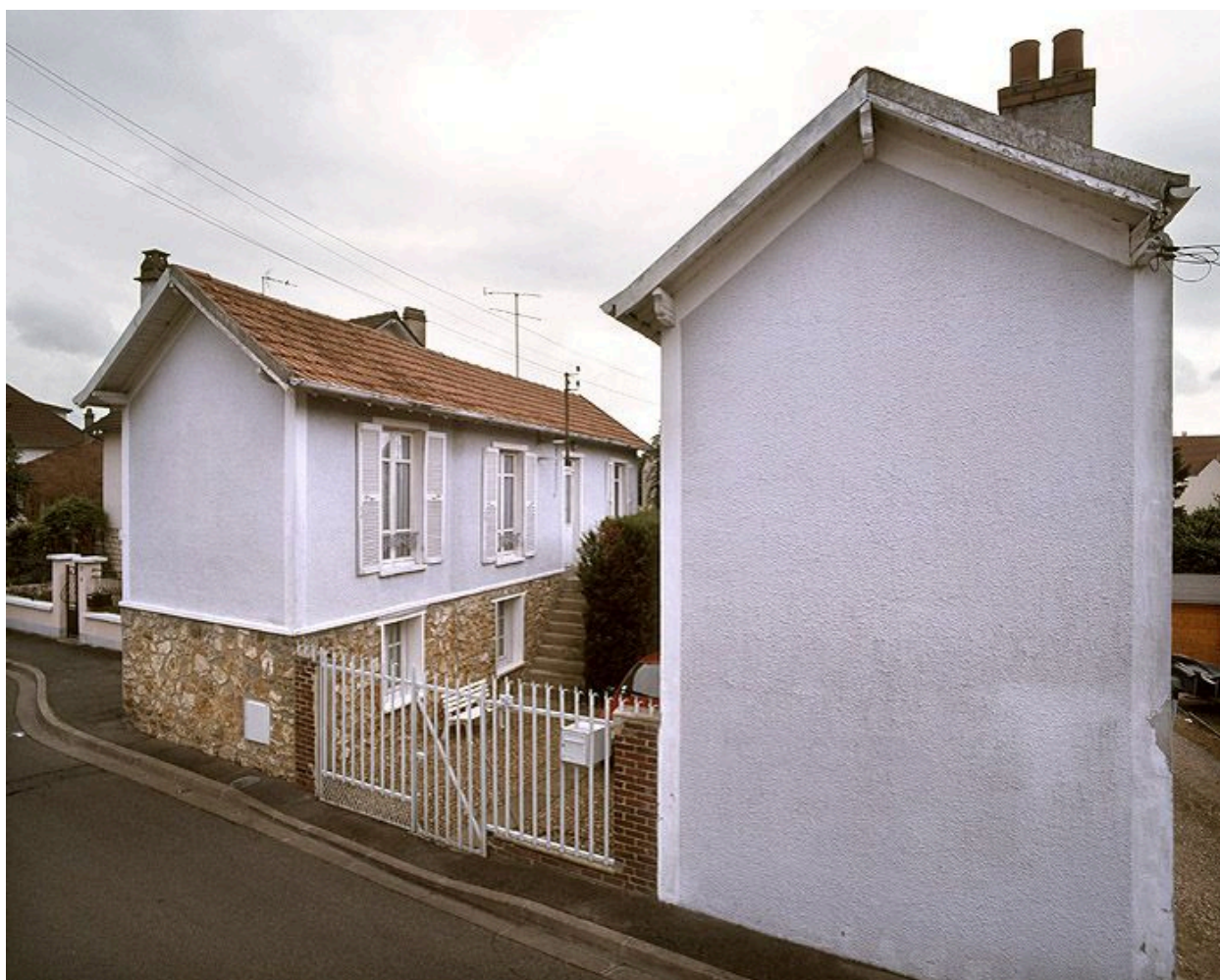
Vue de maisons de marinières implantées perpendiculairement - 39 rue Victor-Hugo.
