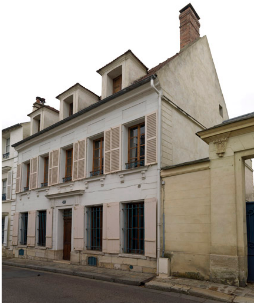
Maison de bourg, 25, rue Sangle. Vue d'ensemble de la façade.
