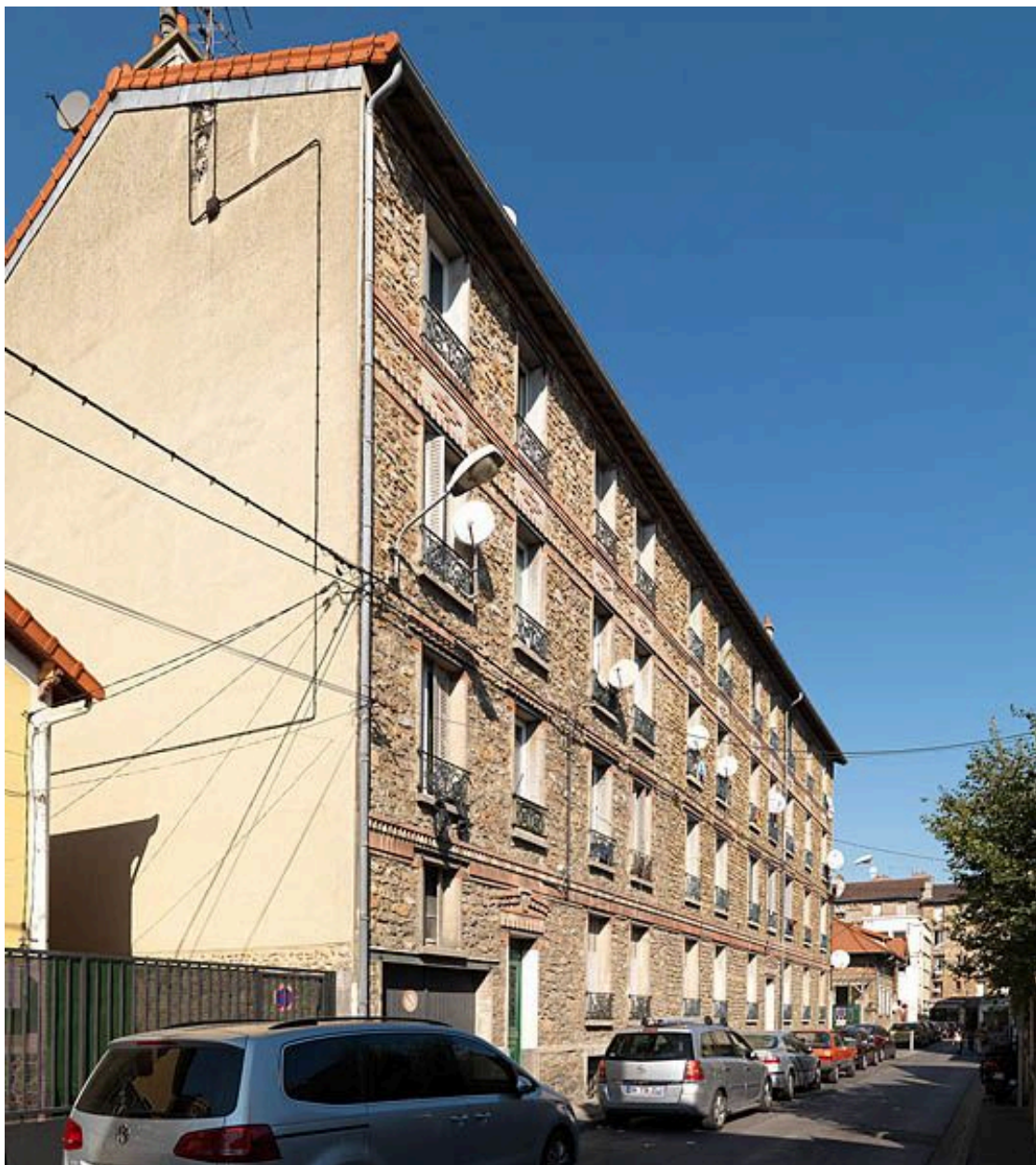
Villeneuve-Saint-Georges, immeuble, 13 rue Victor Hugo. Vue générale.
