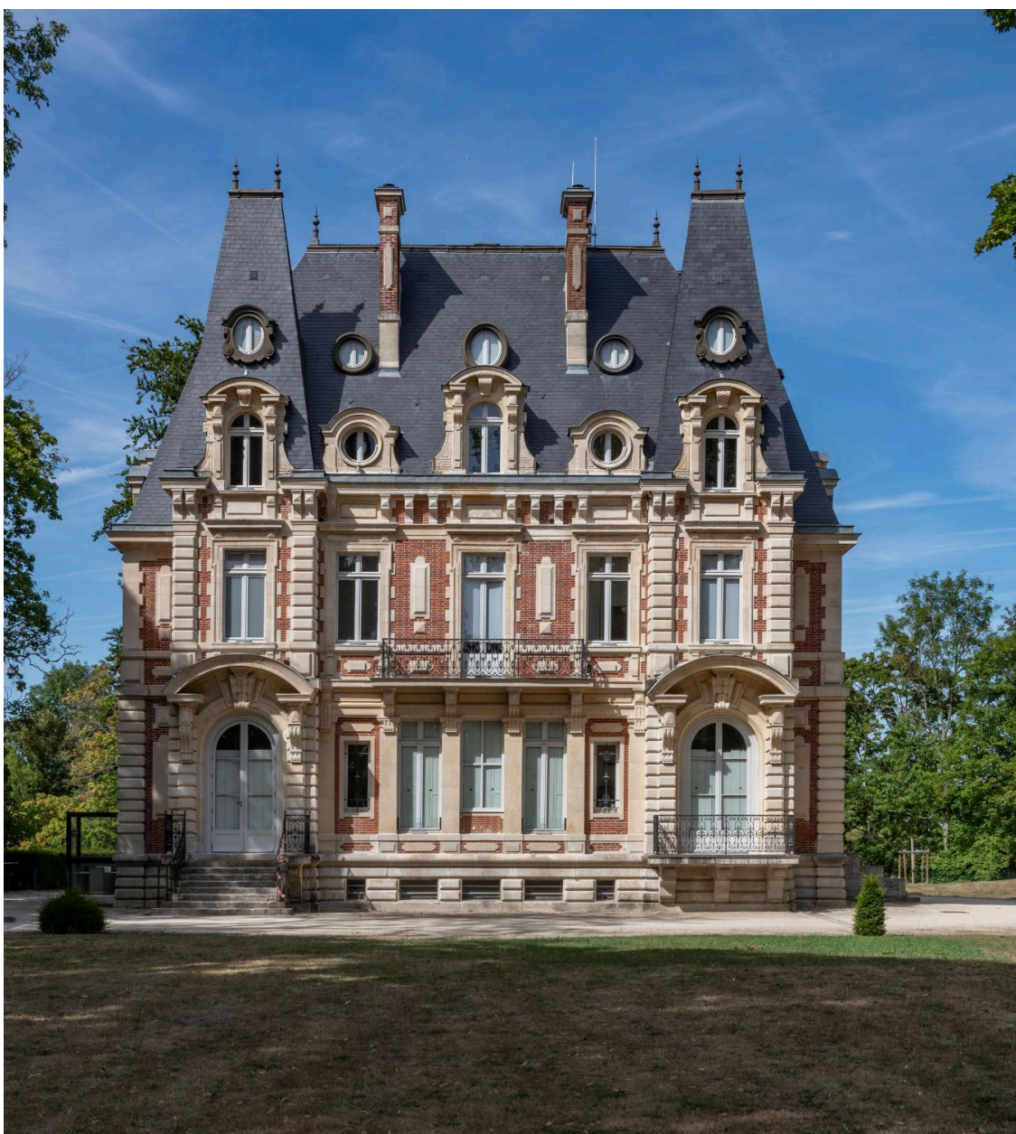
Vue générale du château.
