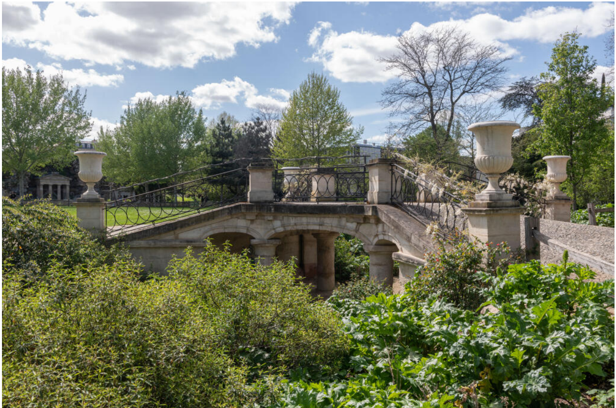
Le pont de pierre, vue d'ensemble.
