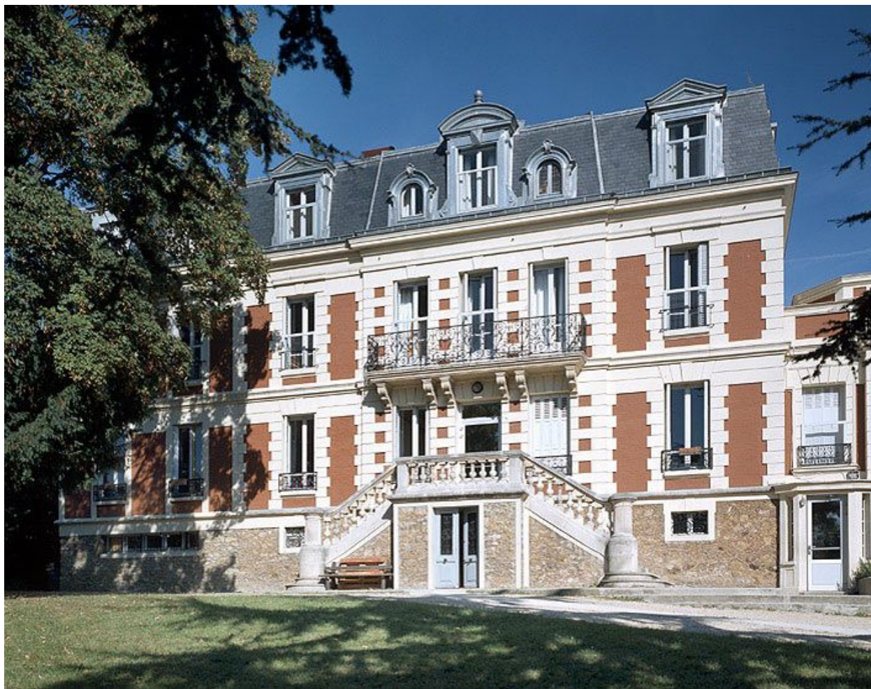
Maison, 8 rue des Défenseurs de Verdun.
