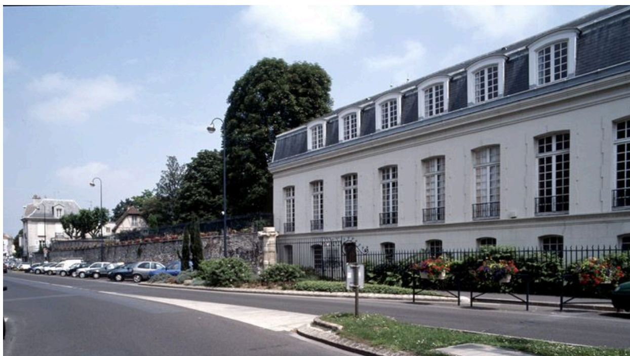
Vue d'ensemble depuis la rue.
