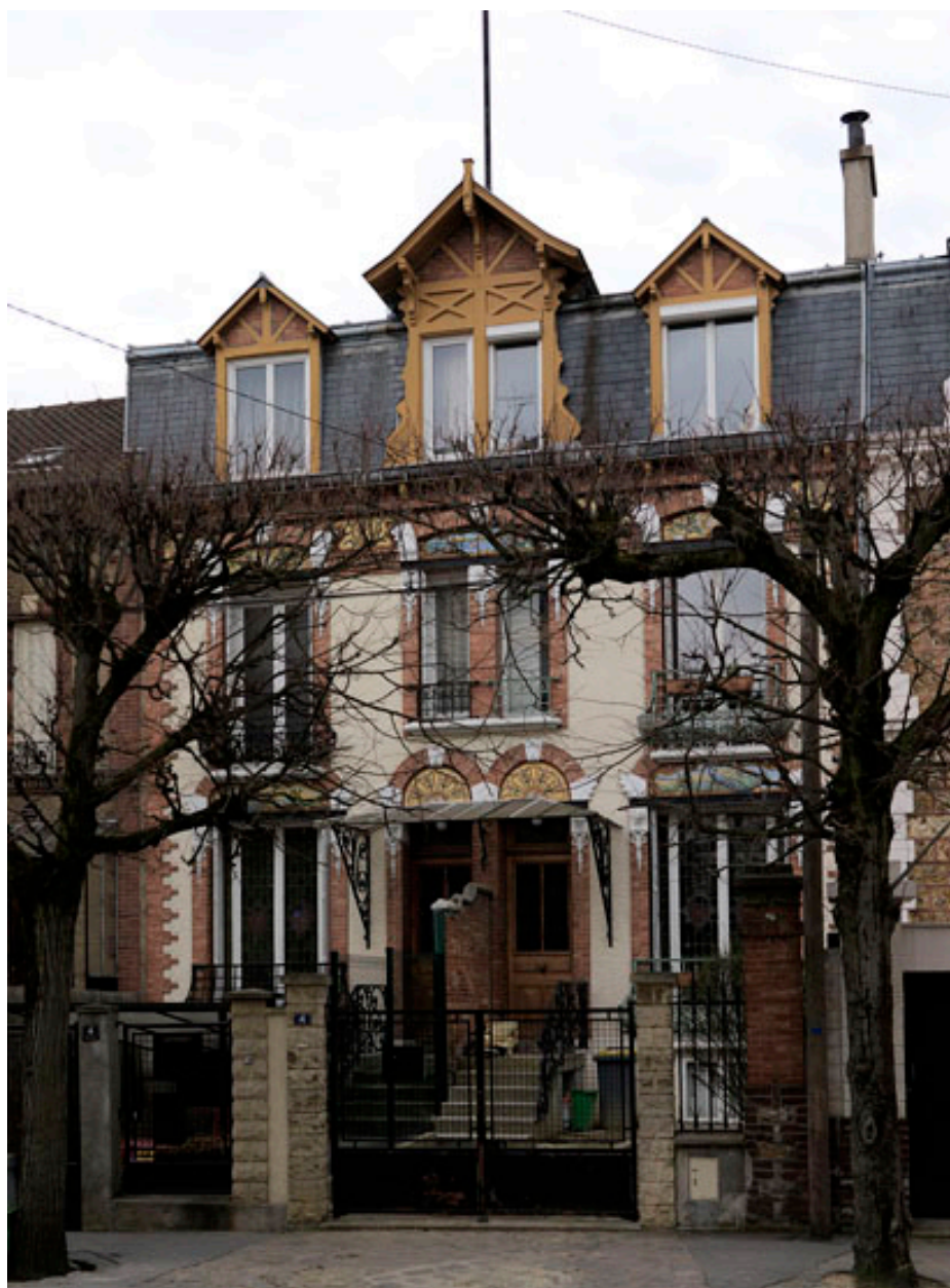
Vue d'ensemble depuis la rue
