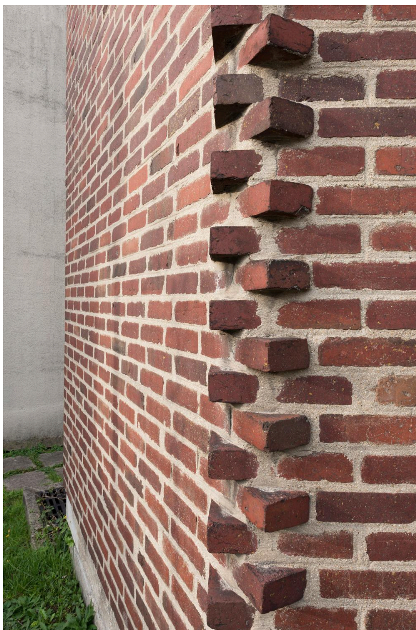
Détail du travail de calepinage de la brique à l'angle de l'un des bâtiments.
