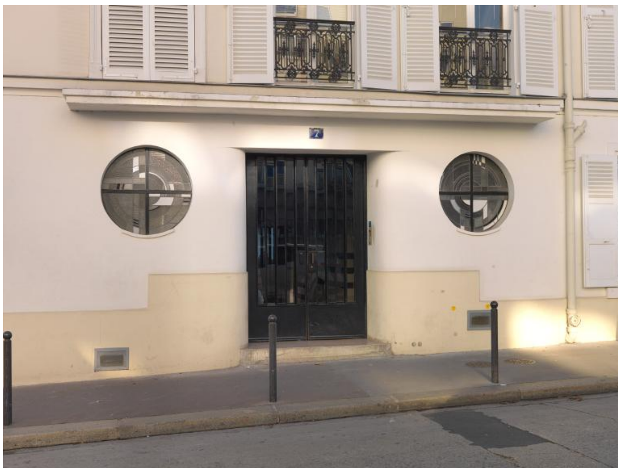
Vue de la porte d'entrée de l'immeuble sur rue
