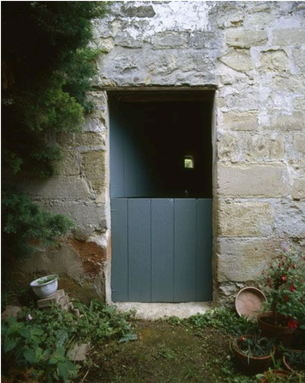
Le bâtiment d'exploitation agricole entre cour et jardin : la porte desservant l'ancienne écurie.
