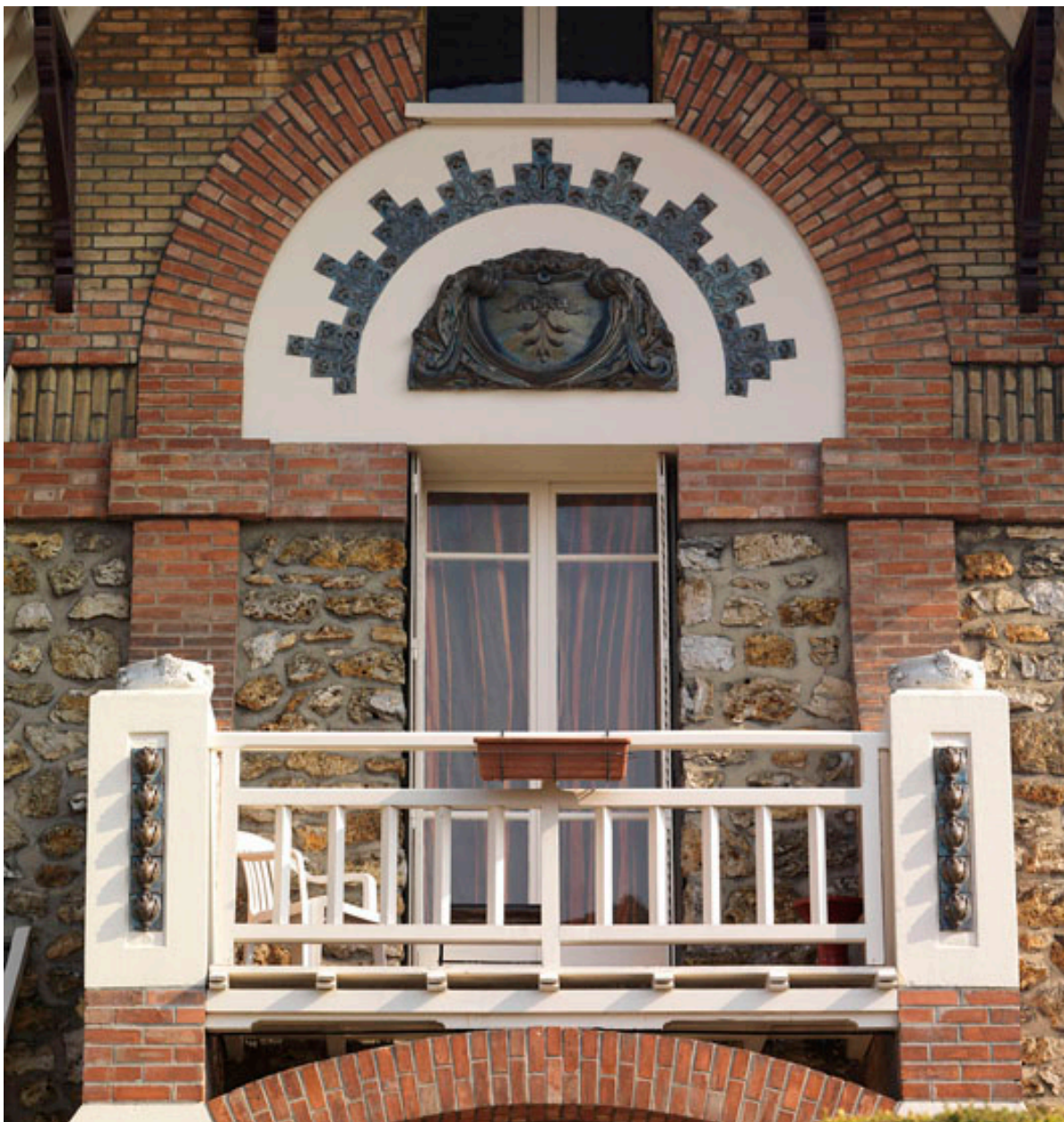
Vue d'ensemble du panneau de céramique formant fronton sur l'une des baies d'une maison construite par Bourniquel.
