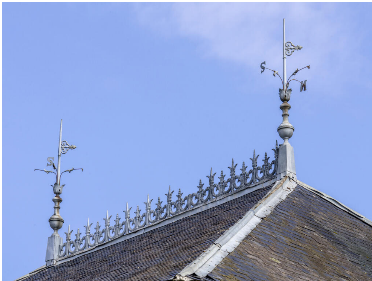
Vue de la crête de toit.
