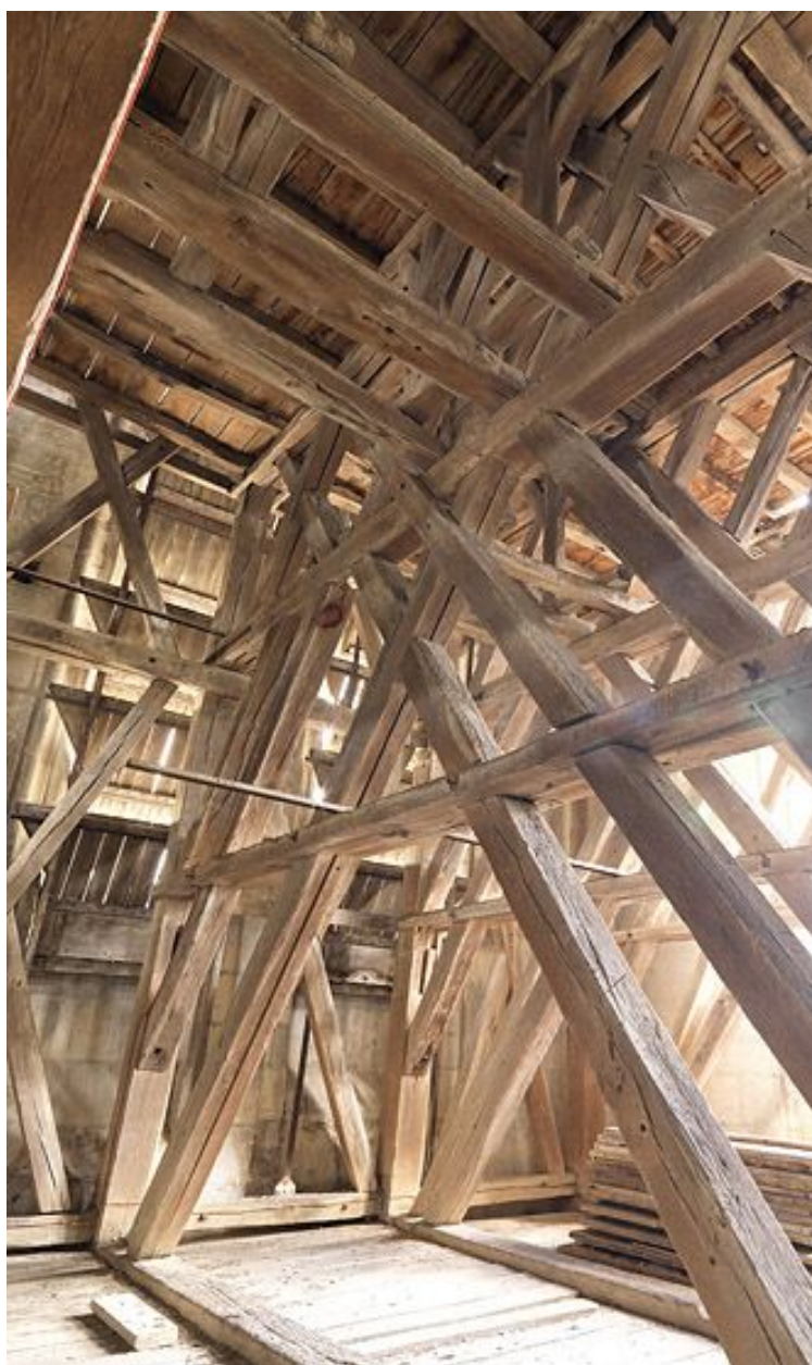
Tour nord, 3eme étage : le beffroi supportant les cloches.
