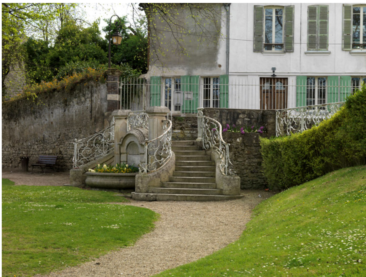
Une volée de l'escalier extérieur.
