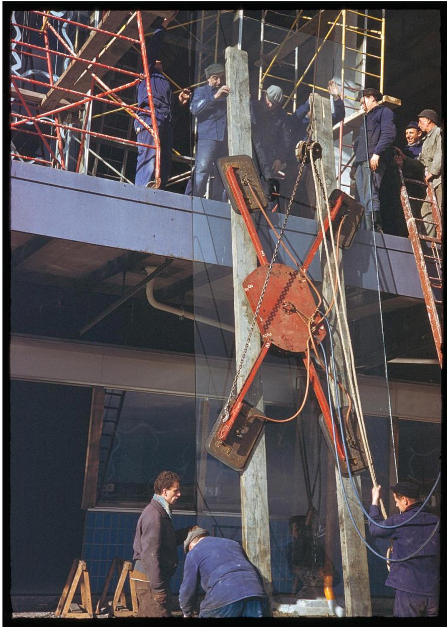
1957 1961, la construction des Installations Terminales: l'installation des dalles en verre du mur-rideau de la façade sud, vue prise depuis le sud ouest.
