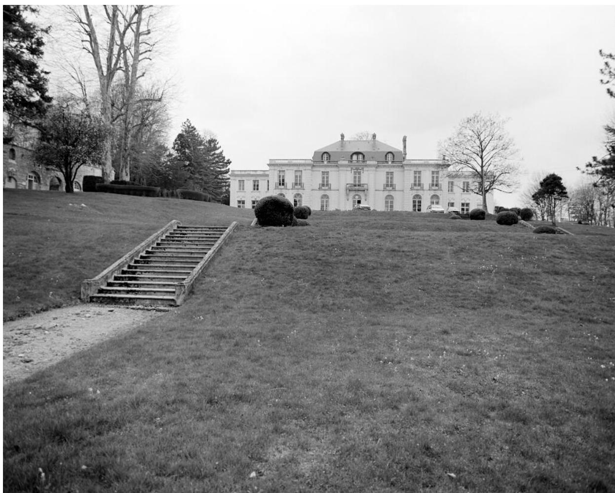
Façade antérieur, vue générale.
