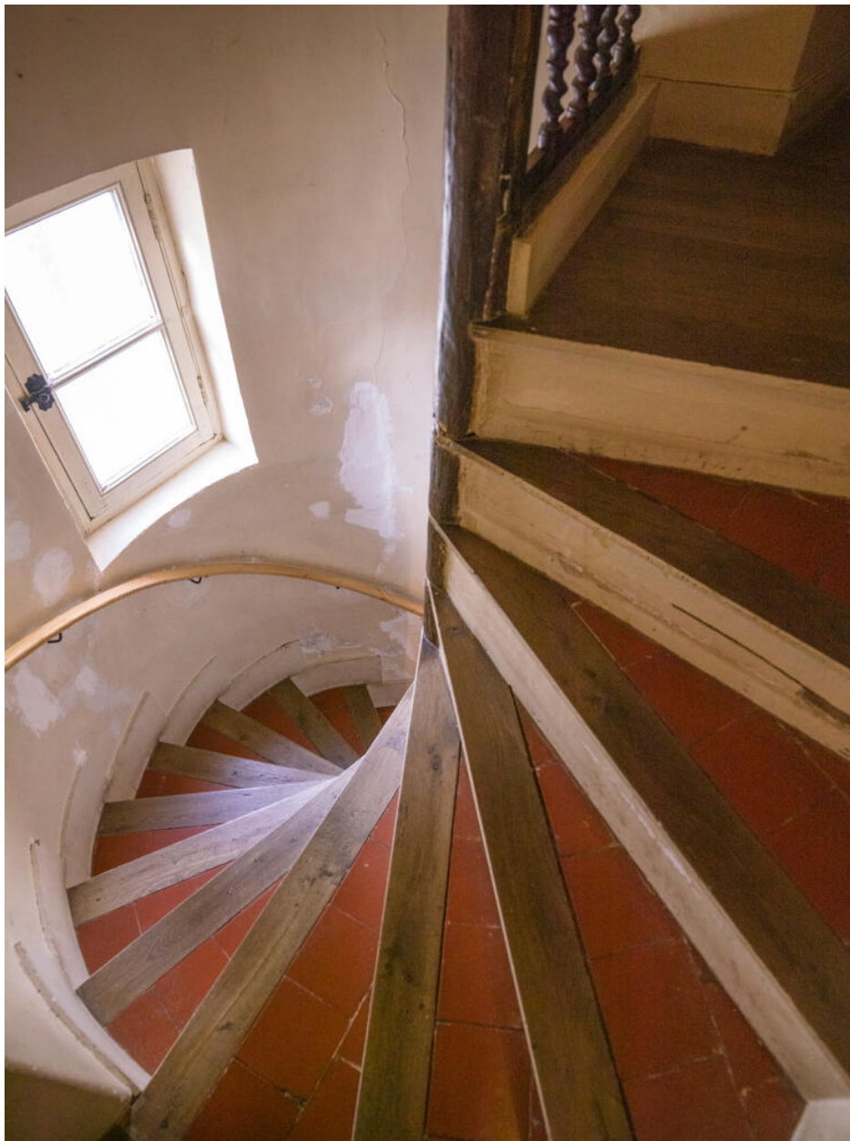
Vue générale de l'escalier en vis.
