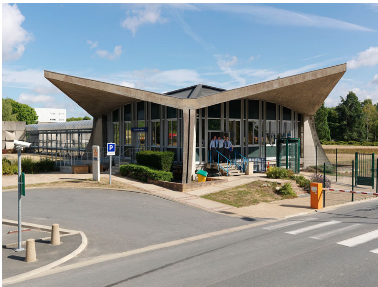
Le pavillon d'accueil des Renardières de René Sarger.
