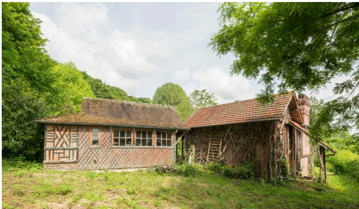
Vue des façades arrières des ateliers (2)
