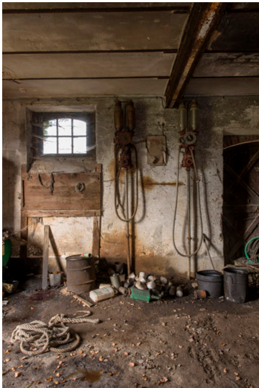
Vestiges de pompes à essence dans l'annexe de l'angle nord est.
