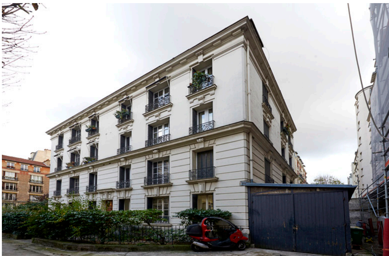
Vue du premier pavillon situé à droite de l'allée.
