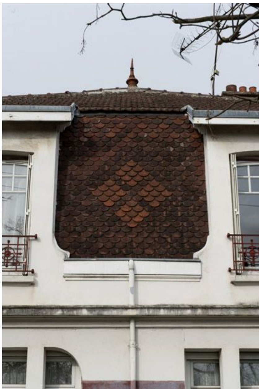
Maison, 8, boulevard de Mantes. Détail des tuiles en écaille du brisis.
