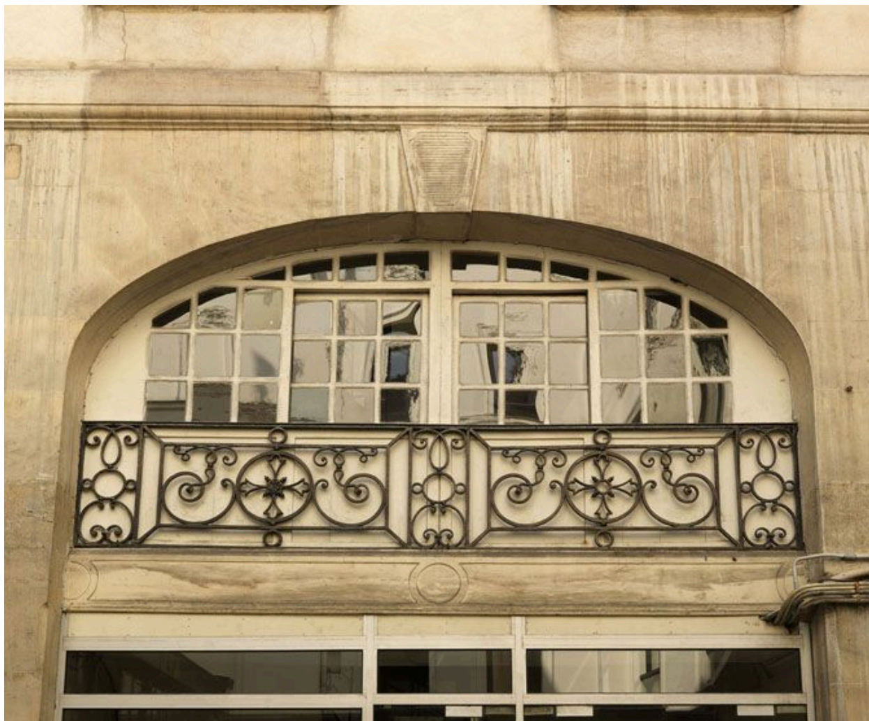
Vue d'un garde-corps, 22 rue du Sentier.
