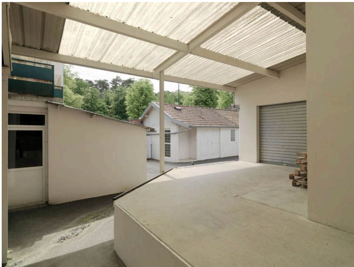
Quai de chargement.
