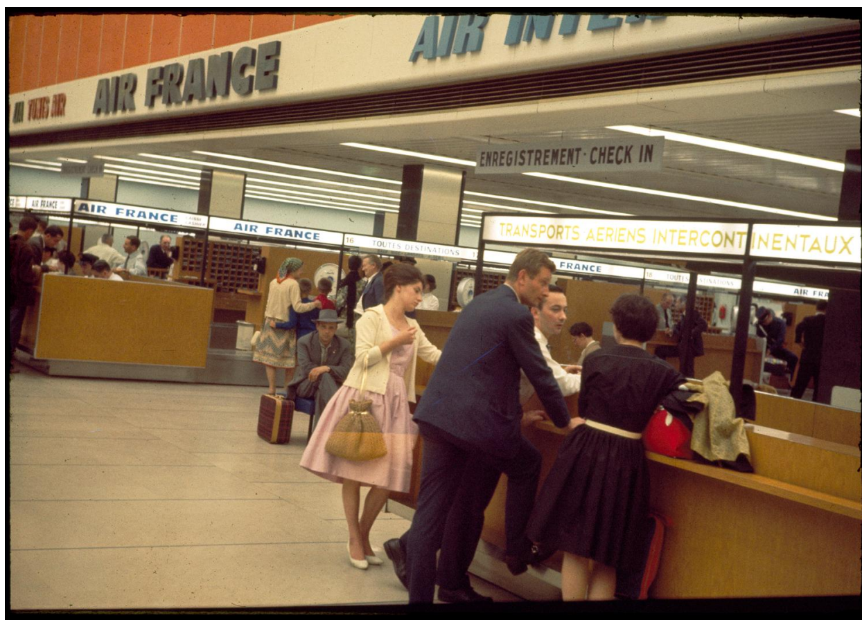
1962, le Grand Hall, les comptoirs d'enregistrement dans la zone départ, rez-de-chaussée.
