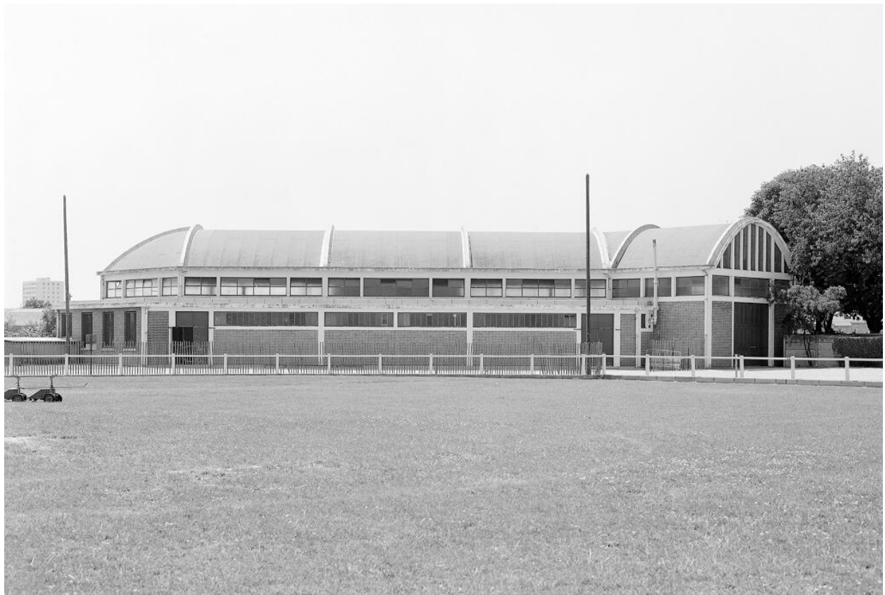
Vue du gymnase prise depuis la piste. Stade Jack-Baudequin
