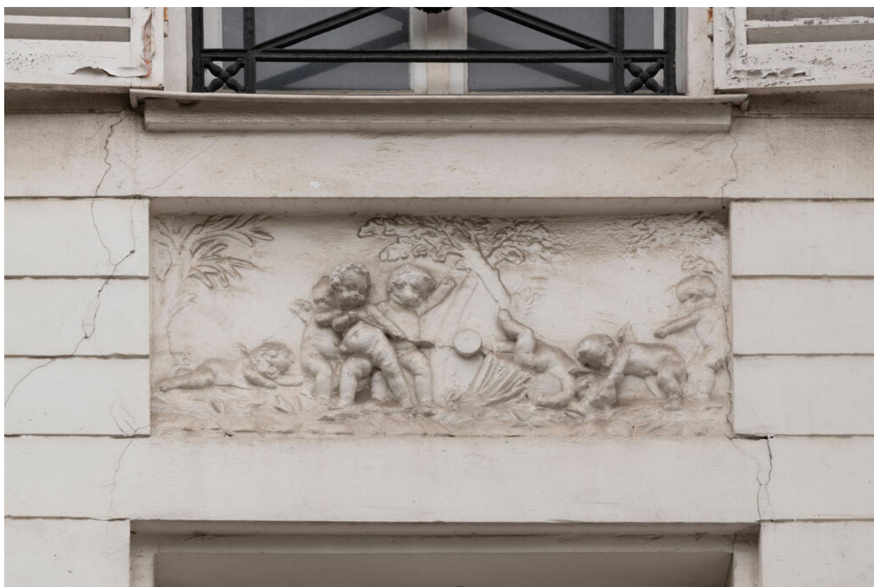
Façade antérieure, détail du bas-relief à droite.
