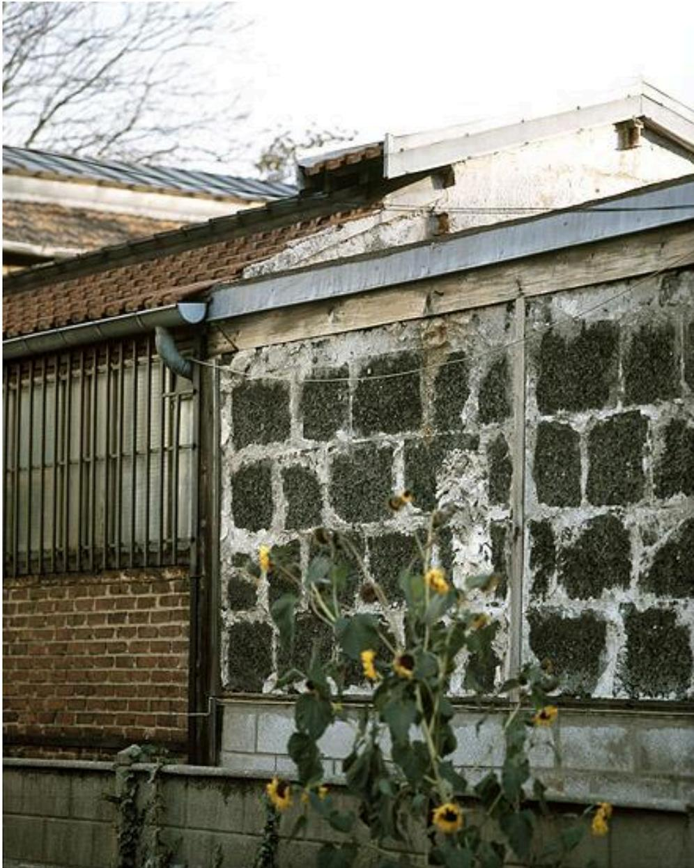
De droite à gauche : mur extérieur du magasin aux modèles, en parpaings de mâchefer (1er quart XXe siècle) ; mur de la halle de sablage, en brique pleine (1947-1949).
