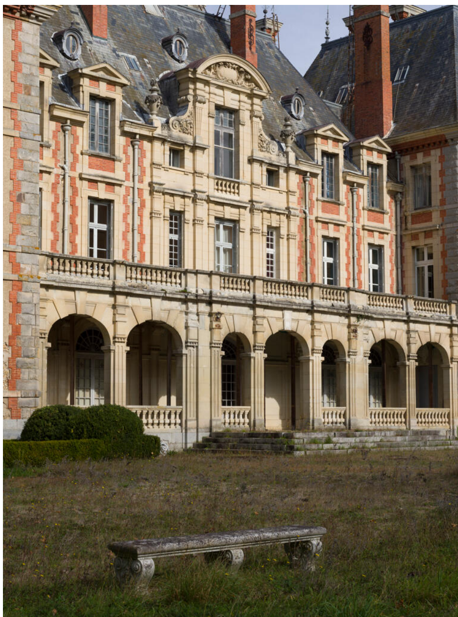
Galerie de la façade sud.
