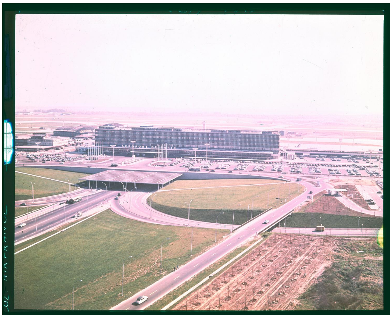
1961 février octobre, les travaux de jonction des Installations Terminales et de l'Aérogare-Sud, vus depuis le nord ouest.
