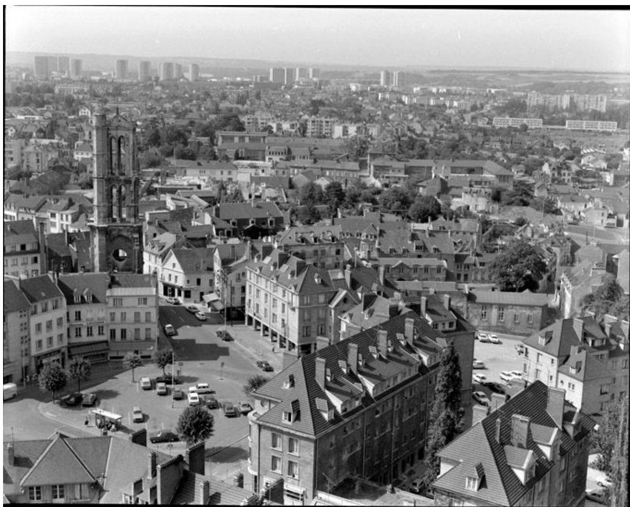
Vue depuis les tours de la collégiale des immeubles reconstruits place Saint-Maclou.
