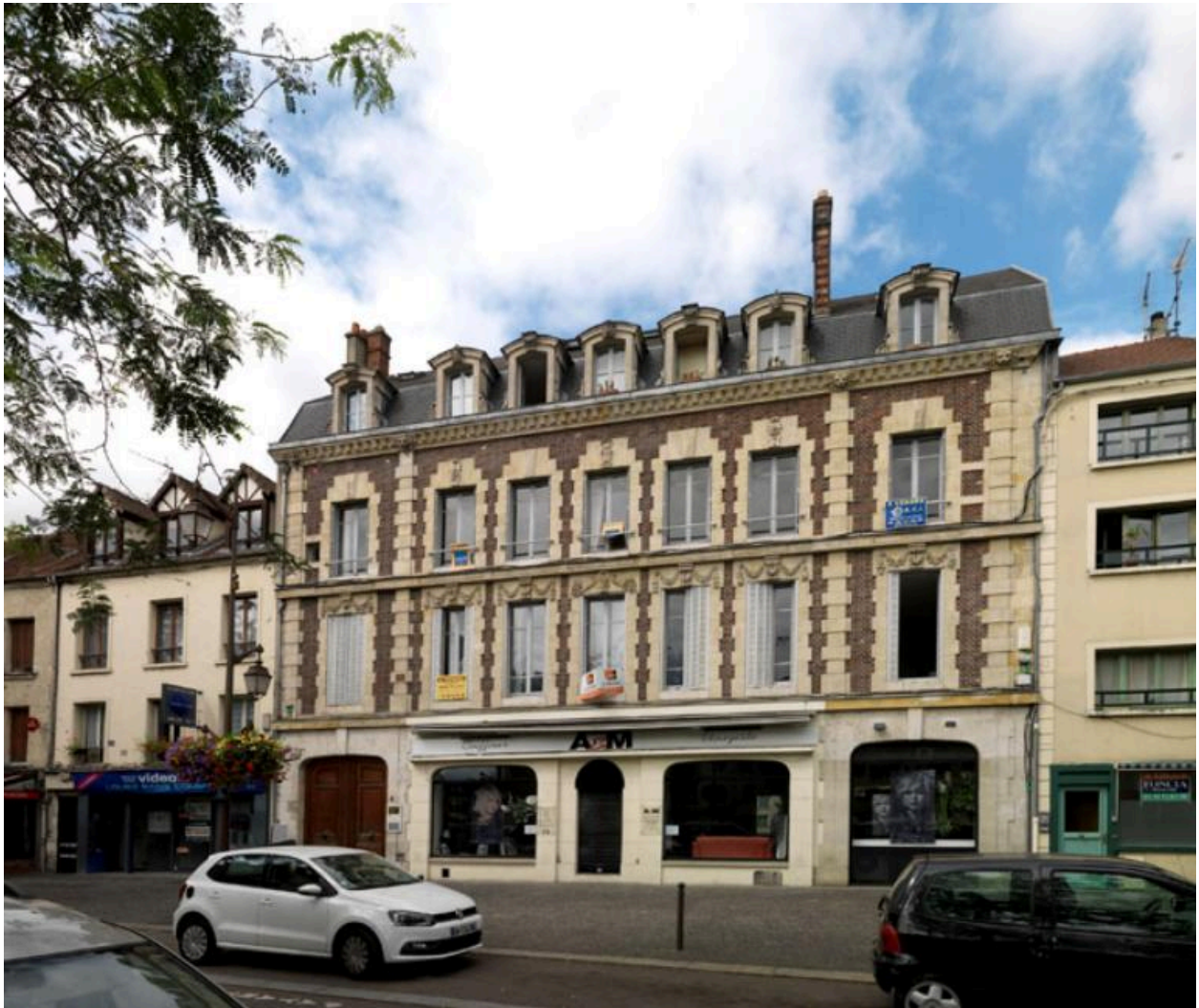
La façade principale.
