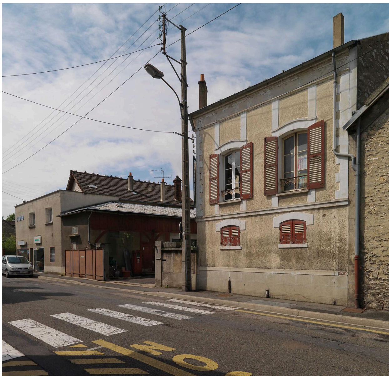
Entrée de la corderie et logement patronal.
