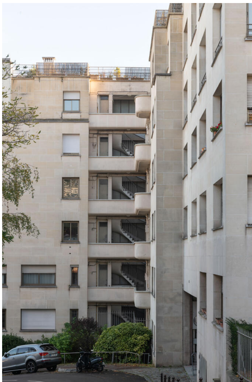
Ensemble des Gâte-Ceps, escalier de service
